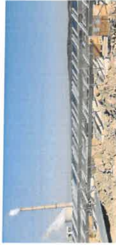
Photo 3 : Mise en oeuvre de structures en châssis fixes (Source : URBASOLAR)
