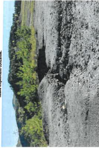
Photo 44 : Prise de vue n°5 : Un des légers entassements pluviométriques sur la plateforme nord Une partie des eaux de ruissellement se concentrent en un point du talus, entraînant une érosion de ce dernier. L'érosion est cependant limitée par le faible impluvium concerné.
