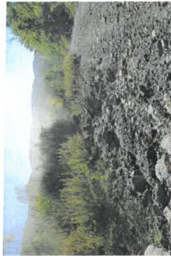
Photo 40 : Prise de vue n°1 : Erosion le long de la piste d'accès ouest de la plateforme sud Les eaux de ruissellements en cas de débordement de la zone de rétention au niveau de la buse D500 ont causé une érosion sur le bord du chemin d'accès.
