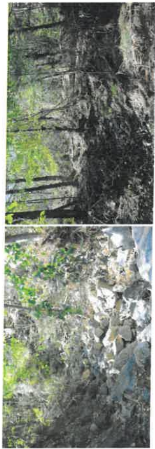
Photo 28 : Prise de vue n°1 : Zone de rétention provisoire La rétention provisoire ne semble pas faire l'objet d'un entretien entraînant de fait un comblement de la zone par des matériaux divers (cailloux, sable, roches, végétaux)
