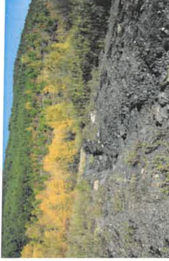
Photo 47 : Prise de vue n°8 : Erosion le long d'un axe d'écoulement sur la plateforme nord Les ruissellements sur la plateforme nord ont entraîné une érosion sur un axe d'écoulement rejoignant le réseau de gestion des eaux pluviales en contrebas de la plateforme nord
