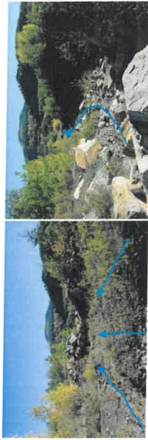
Photo 33 : Prise de vue n°6 : Entrochements lourds En sortie de la zone d'élargissement, une ligne d'entrochement lourd délimite le début du fossé de ruissellement dont le lit est constitué d'entrochement de plus petite taille. Ce fossé dirige les eaux de ruissellement vers le bas de l'ancienne mine, au niveau de la zone de stockage des eaux
