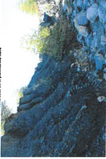
Photo 47 : Prise de vue n°8 : Erosion le long d'un axe d'écoulement sur la plateforme nord Les ruissellements sur la plateforme nord ont entraîné une érosion sur un axe d'écoulement rejoignant le réseau de gestion des eaux pluviales en contrebas de la plateforme nord
