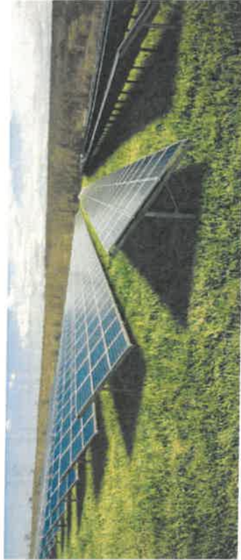
Photo 3 : Mise en oeuvre de structures en châssis fixes (Source : URBASOLAR)
