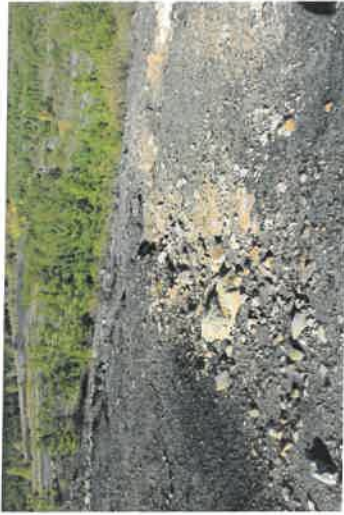
Photo 44 : Prise de vue n°5 : Un des légers entassements pluviométriques sur la plateforme nord Une partie des eaux de ruissellement se concentrent en un point du talus, entraînant une érosion de ce dernier. L'érosion est cependant limitée par le faible impluvium concerné.
