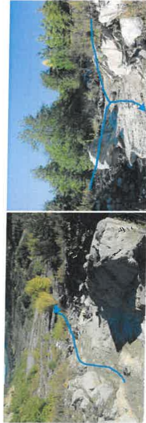
Photo 35 : Prise de vue n°8 : Descente bétonnée Une descente d'envrochements liss entre eux par du béton permet aux eaux de ruissellement d'atteindre le bas du talus en limitant l'érosion
