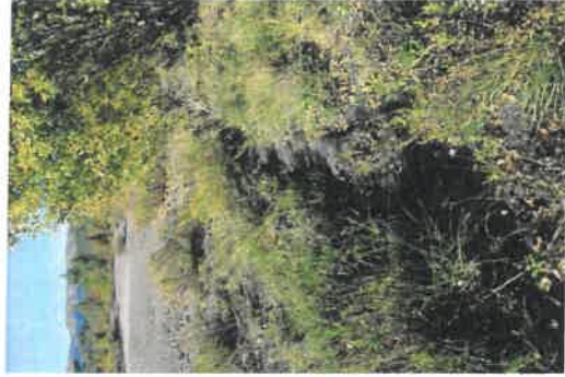
Photo 42 : Prise de vue n°3 : Erosion sur la plateforme sud Les eaux de ruissellements se concentrent sur certaines zones de la plateforme sud entraînant une érosion localisée
